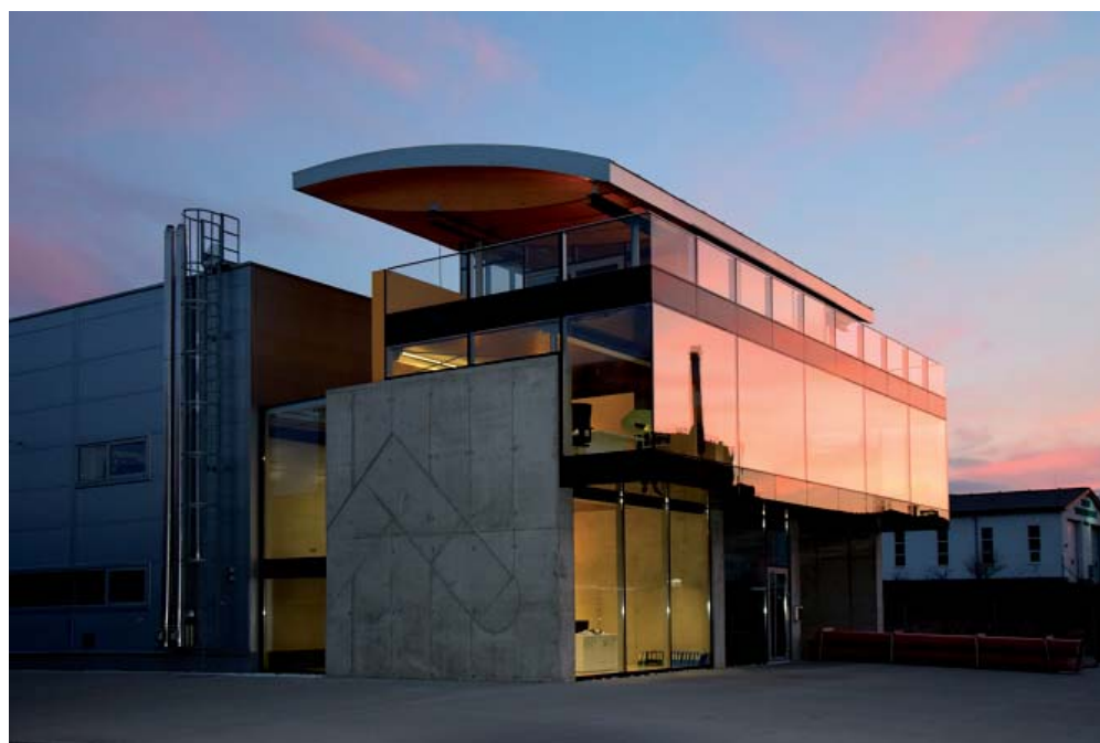
Frontálny útok: určujúci charakter stavby tvorí predná časť, ktorá je komponovaná s citom pre expresívnu figúru. Prostý kváder priemyselnej haly ukrytý za ňou slúži technickej prevádzke firmy.
